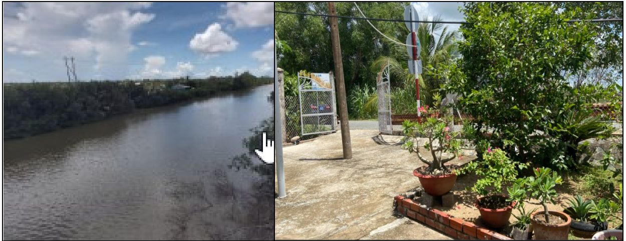
Figure 2: Current conditions at the My An plant: water intake point (left); the road to the plant (right)/ Hình 2: Hiện trạng trạm cấp nước xã Mỹ Hưng: điểm lấy nước – Cầu Mỹ An (tay trái); vị trí đặt trạm (tay phải)
